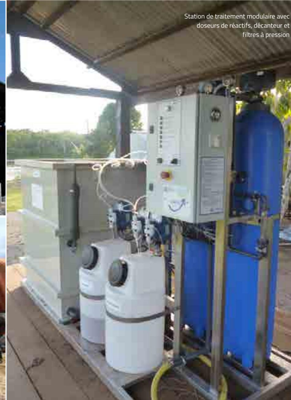
Station de traitement modulaire avec doseurs de réactifs, décanteur et filtres à pression
