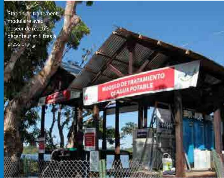
Station de traitement modulaire avec doseur de réactifs, décanteur et filtres à pression
